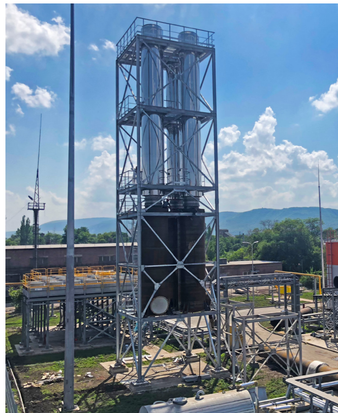
Проект компании «СТМ-ОСКОЛ», Дымовая труба ГПТЭС АО «Евроцемент-Групп» г. Черкесск
